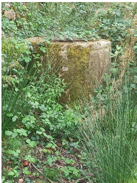
Ilustración 5: Captación da Fraga
