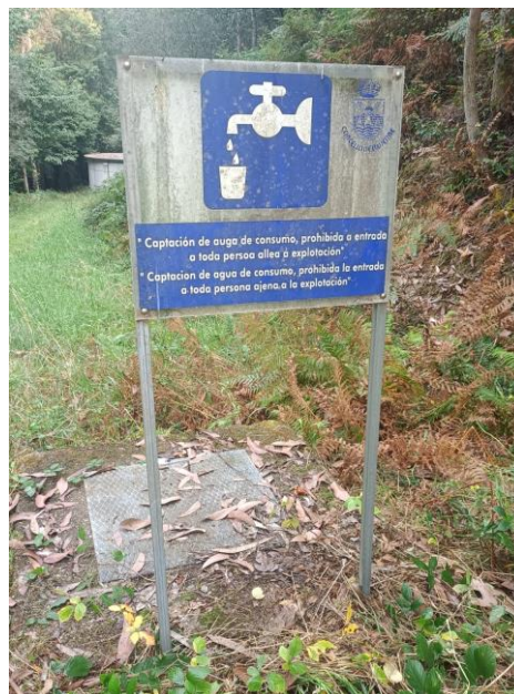
Ilustración 6: Captación da Fraga
